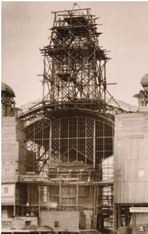
1. Průmyslový palác ve 2. pol. 90. let 19. století, foto František Krátký 2. Střední část Průmyslového paláce ve stavbě, foto Jindřich Eckert, 1891 3. Ocelové nýtované nosníky levého křídla, foto Jindřich Eckert, 1891 4. Letecký pohled z balonu Františka Hůlky, foto Jan Plischke, 1906 5. Střední hala paláce v době Zemské jubilejní výstavy 1891, foto Jindřich Eckert
