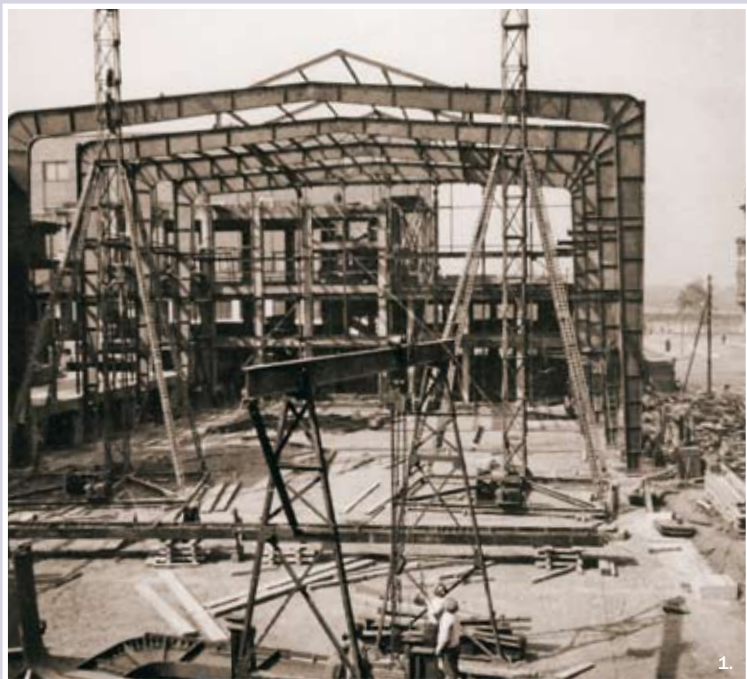
1. Ocelová konstrukce dopravní haly 2. Národní technické muzeum po dokončení 3. Pohled na rozestavěné zemědělské muzeum 4. Západní křídlo budovy technického muzea 5. Architekt Milan Babuška (zcela vpravo)
