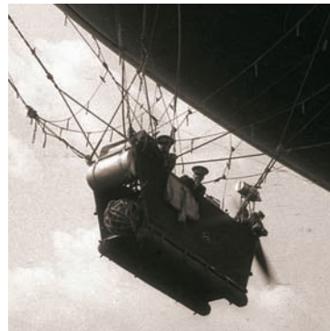
Historický snímek balonové gondoly z 30. let 20. století; Trubková konstrukce gondoly
